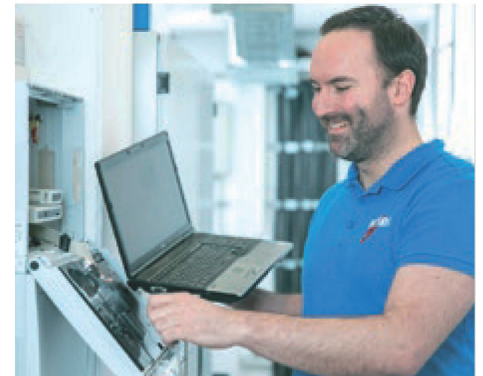
Andreas Klein bei der Programmierung einer Brandmeldeanlage
